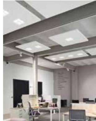
**#58 Soundlight Comfort von Philips und Saint-Gobain Ecophon:** Das System kombiniert eine Akustikdecke mit hochwertiger, energieeffizienter LED-Beleuchtung. Dank Vorverdrahtung reduzieren die freihängenden Paneele das Kabelgewirr. Sie eignen sich auch für betonkernaktivierte Decken.
